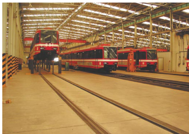
Base de Mantenimiento Tetlán del Tren Ligero.
